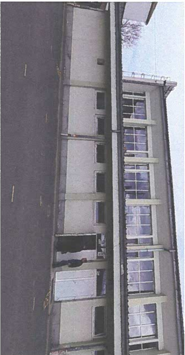
Poza 1. Fatada principala. Se observa unele infiltratii la soclul Anexei
