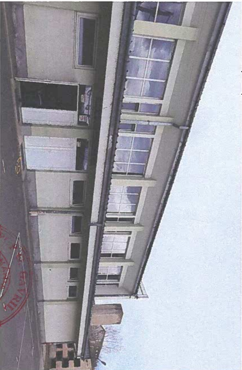
Poza 2. Fatada principala. Burlan necorespunzator
