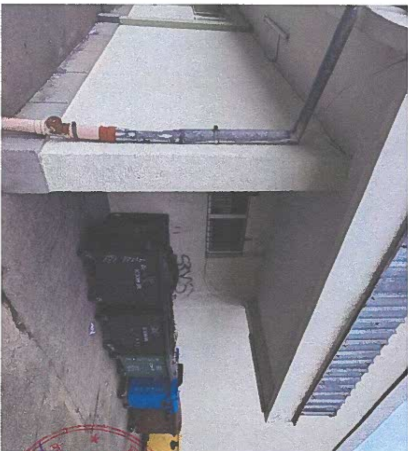
Poza 8. Degradari la nivelul tencuiei terasei de beton de peste anexa.
